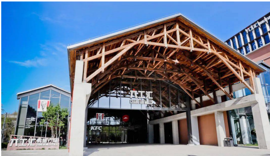
北京首钢园. 六工汇购物广场的东侧主入口由原首钢第二泵站改造而成, 保留了建于上世纪30年代的木制结构 (图片来源: 搜狐)
